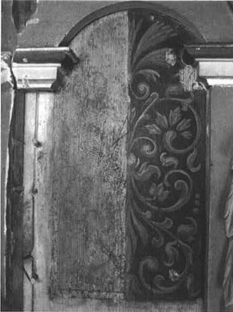
Abb. 3: Ein Füllungsfeld der Arkaden bei den Freilegungsarbeiten. Rechts ist die Bemalung von vermutlich 1929 erkennbar und links die freigelegte Originalfassung von ca. 1639. Foto: Janko Barthold
